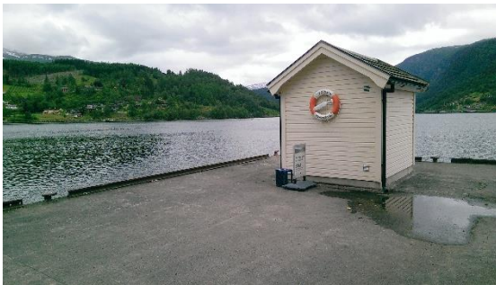
Ny hovudkloakkpumpestasjon på kaia.
