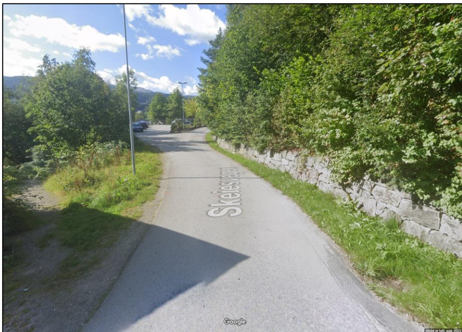
Figur 3-27: Skeiesvegen på vestsida av Skulebrua. Foto: Google Street View.
