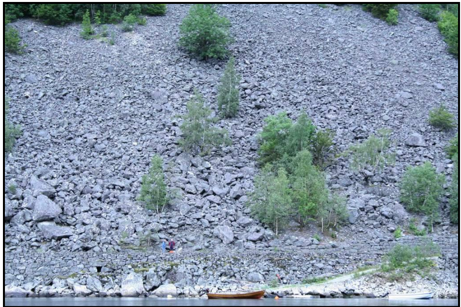
Nærverknad av ura. Veg og ur går nærast i eitt. Ura er planlagt fullstendig fjerna.
