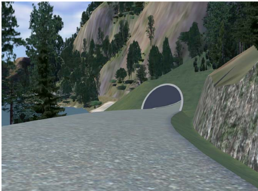
Figur 15 Eddegjelet med tunnel sett frå vegen. Portal med overdekning for skredbane, skredvoll og fylling vidare fram til fjorden.
