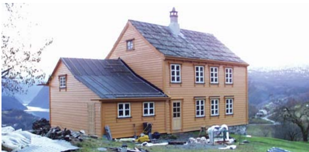
Bustadhus på Oppheim under rehabilitering.
