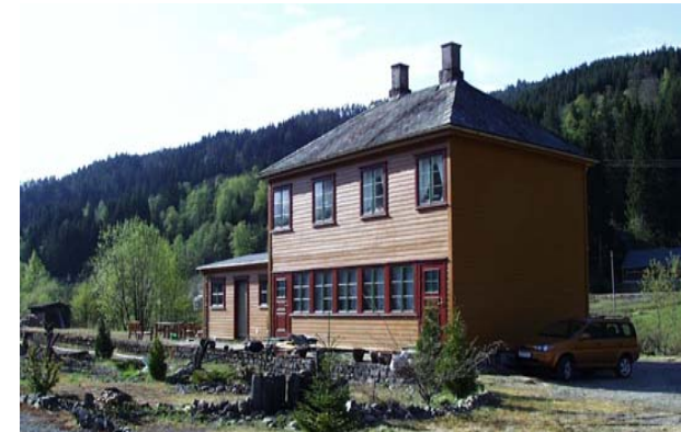
Gamle stasjonsbygningen på Nesheim er rehabilitert og bygd om. Den inneheld no bustad i 2 høgda og atelier i 1. høgda.
