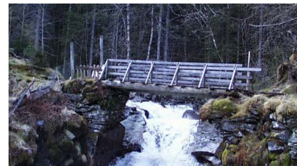
Gangbru over Hyrpo.
