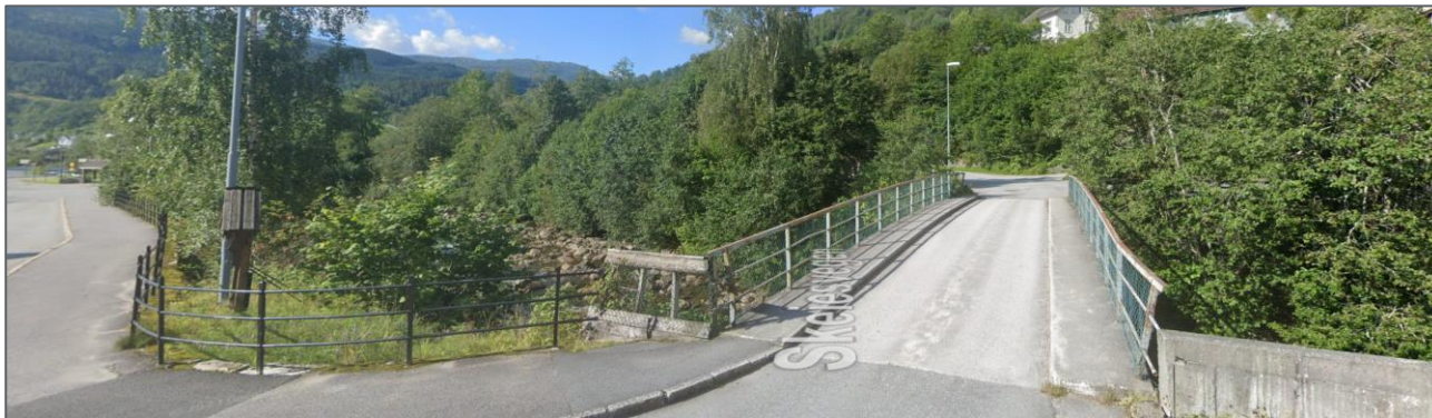
Figur 2-10 Gangarealet over brua er smalt og lite eigna for trygg ferdsle for skuleborn. Lengst til venstre skimtar vi busstoppet der elevane går på/av bussen. Det er vurdert ei løysing med ny gangbru knytt til dette stoppet.
