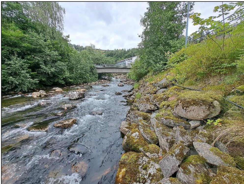
Figur 5-2: Bilete av eksisterande sikring, tatt motstraums.
