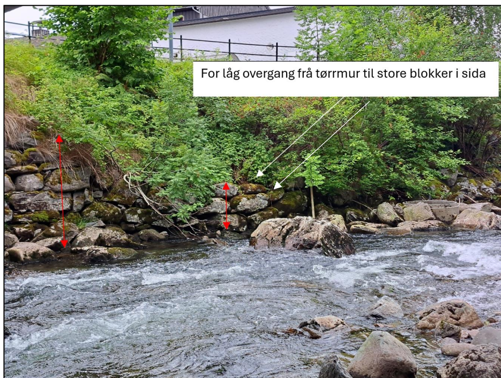
Figur 5-3: Bilde av overgang fra tørmur til sidesikring, medstraums.
