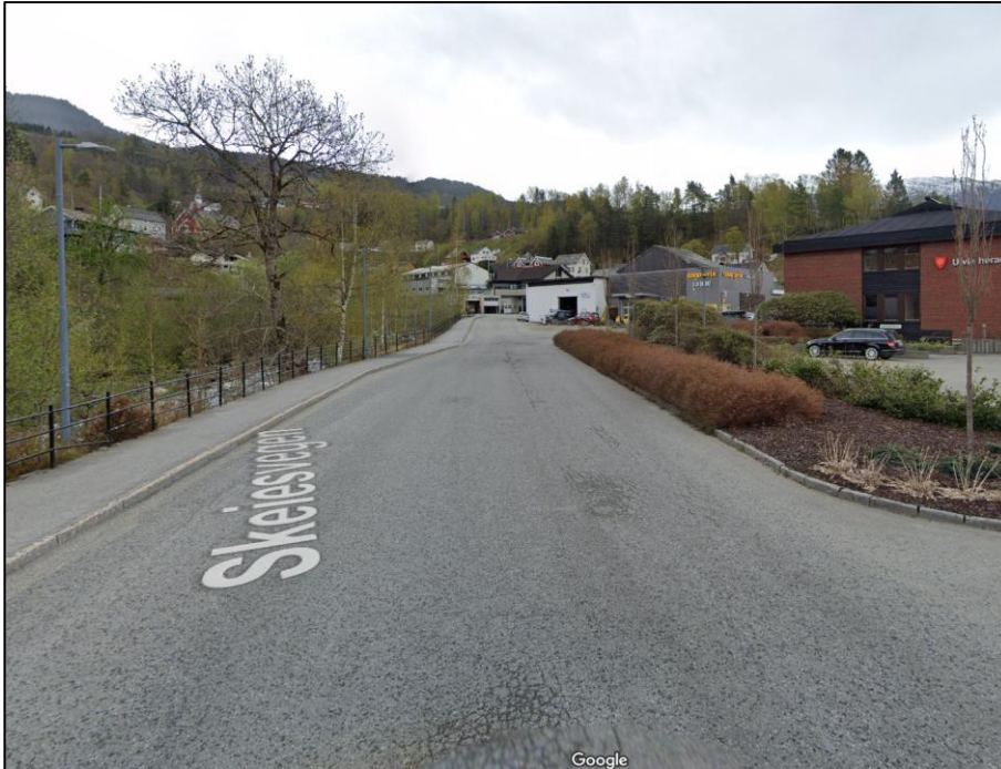
Figur 3-24: Skeiesvegen mellom fv. 572 og Skulebrua. Foto: Google Street View.
