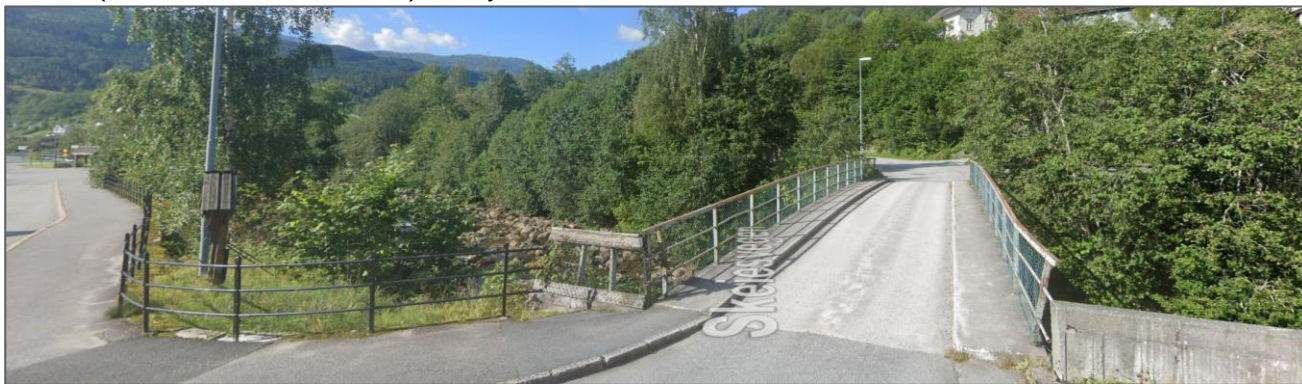
Figur 4-8 Gangarealet over brua er smalt og lite eigna for trygg ferdsle for skuleborn. Lengst til venstre skimtar vi busstoppet der elevane går på/av bussen. Det er vurdert ei løysing med ny gangbru knytt til dette stoppet.
